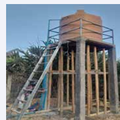
完成したトムアット村 診療所貯水タンク
